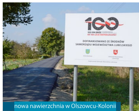
nowa nawierzchnia w kierunku Olszowca-Kolonii
