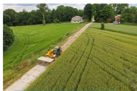
Wincentówek. Podczas demontażu płyt drogowych (2019-06-18)
