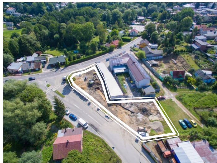
Parking przy ul. Podwale – w trakcie prac (2019-08-12)
