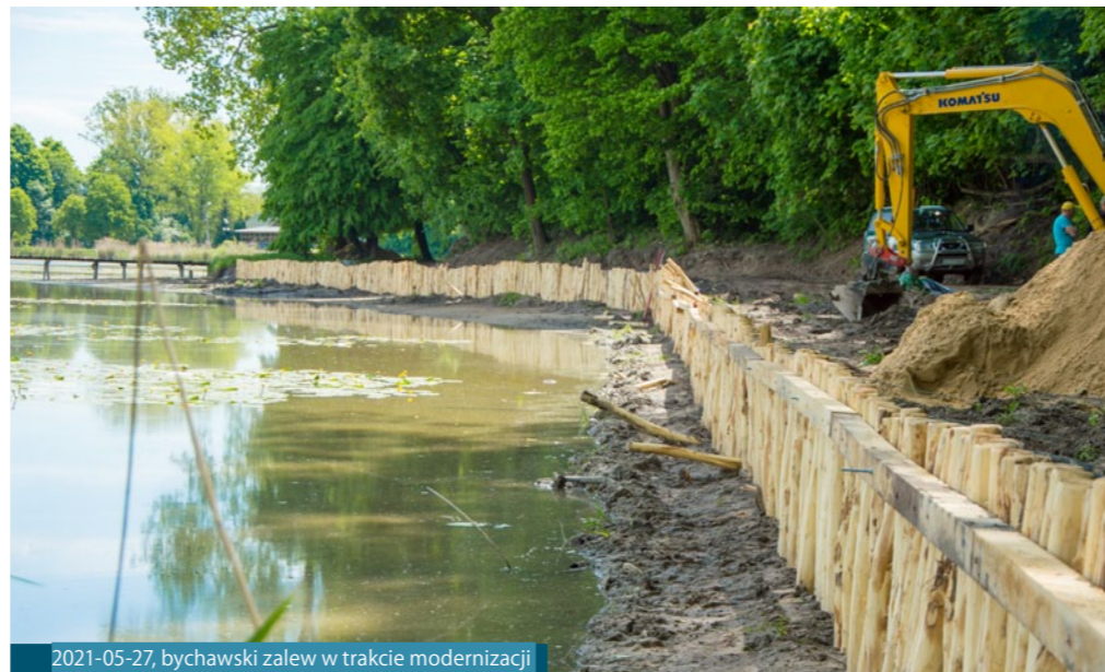
2021-05-27, bychawski zalew w trakcie modernizacji
