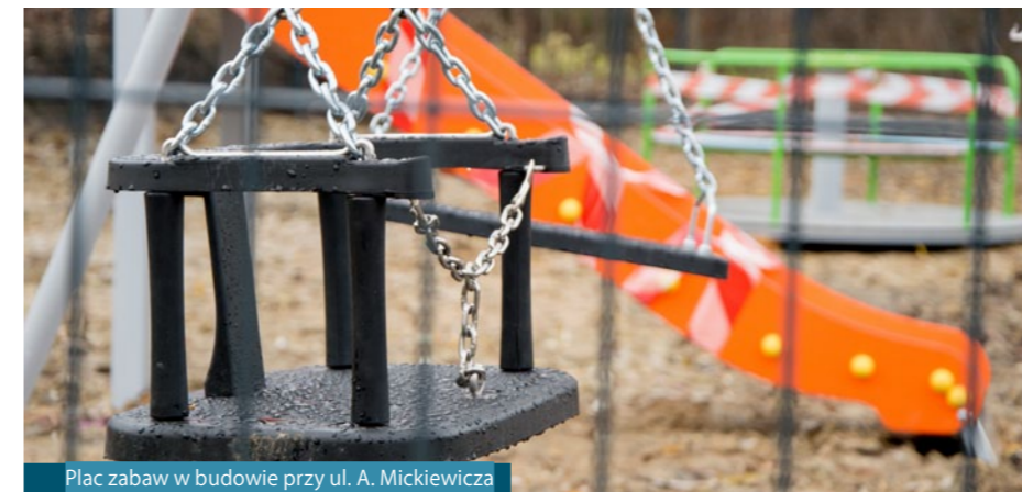
Plac zabaw w budowie przy ul. A. Mickiewicza
