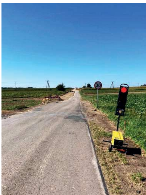
Przebudowa drogi Bychawa-Olszowiec-Romanów – inwestycja w bezpieczną przyszłość!
